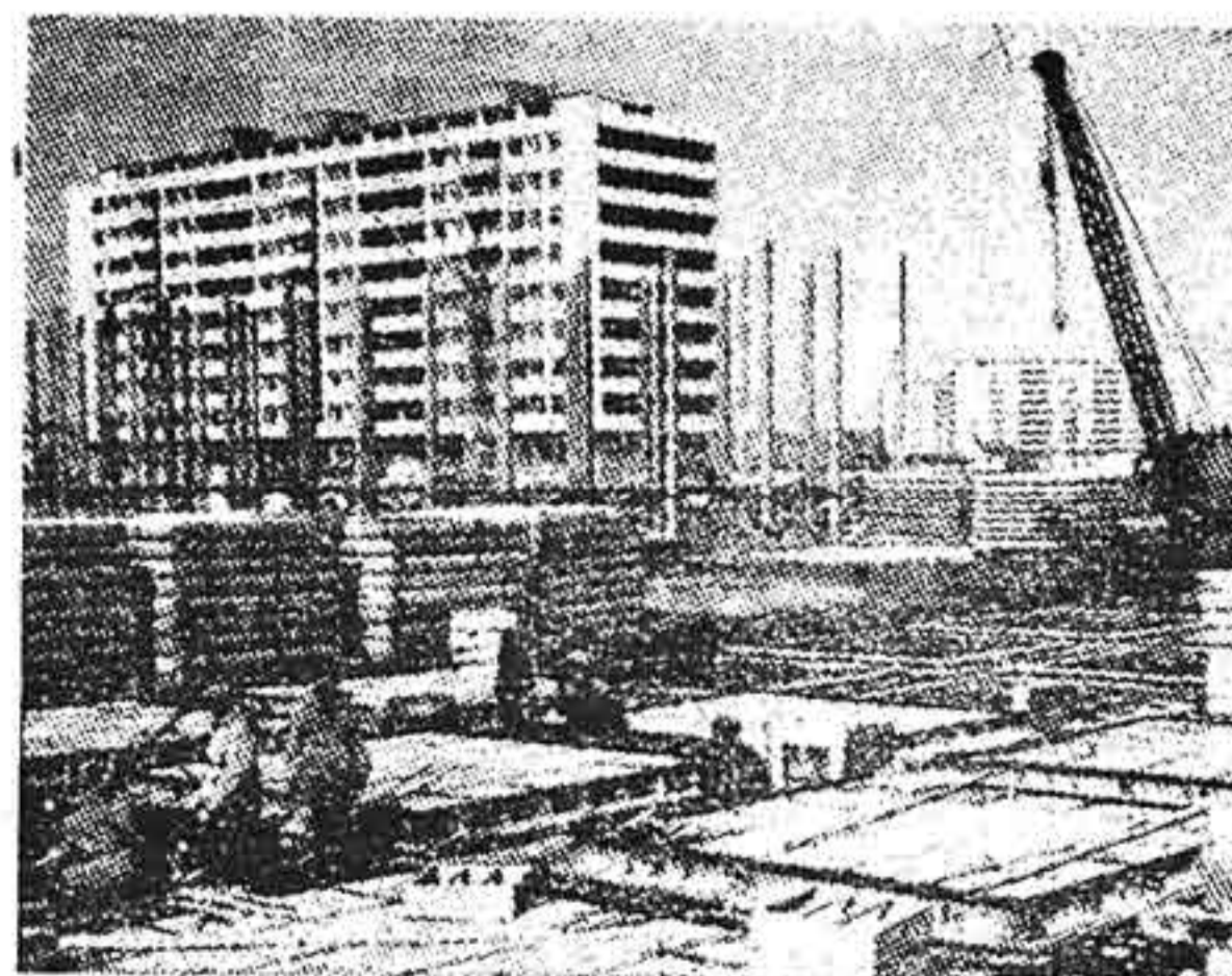
Construyendo viviendas en Belgrado
